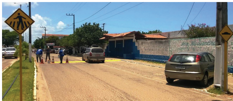
Foram instaladas 49 placas de regulamentação de trânsito, 40 de advertência e outras dez de caráter indicativo
